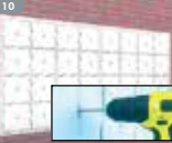
Bei einer Installation an der Wand: Bohren Sie ein Befestigungslöcher in die Mitte jeder Zelle. Entfernen Sie bitte erst die Schablone, bevor Sie die Dübel installieren.
