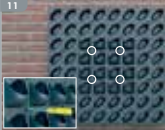
Positionieren Sie nun Ihre G-WALL und befestigen Sie die vier mittleren Zellen mit geeigneten Schrauben durch die Befestigungsdorne in den entsprechenden Befestigungslöchern.
