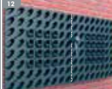
Montieren Sie das nächste Paneel gemäß den Schritten 1-8. Verbinden Sie dieses nun mit dem bereits befestigten Paneel gemäß Schritt 11. Wiederholen Sie den Vorgang, bis Sie die gewünschte Form erhalten haben.
