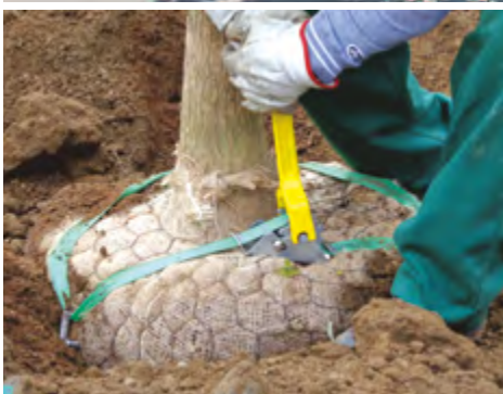
Baumverankerungssystem: Deadman Plati-Mat® & Spezial-Gurtband
